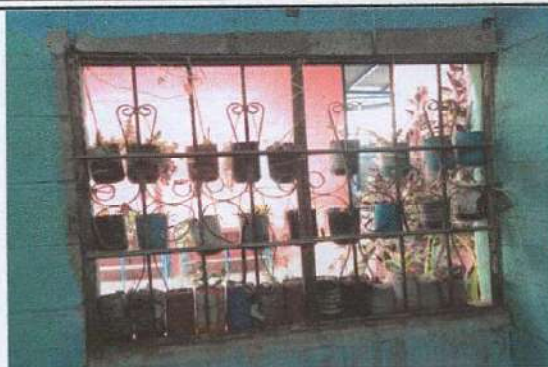
Foto 2: Mantenimiento oxidado a balcón de la dirección lijado y pintado.
