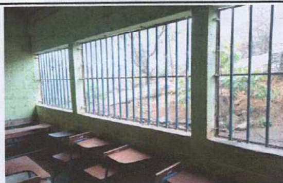
Foto 4: Sustitución de balcones oxidados en una aula por balcones de metal.
